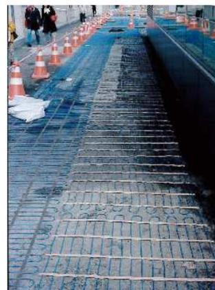
「札幌グランドホテル」を札幌駅に向かうと、昨年まで建っていた「日本生命の建物」の取り壊し工事が終わっており、白い仮囲いの板が廻らされていた。板に面した歩道も工事中であったが、工事用のレッドコーンで囲われた部分に、写真のようなロードヒーティング用の電線がはられていた。こんなロードヒーティングの構造が分かる状態を目にすることは、珍しいので写真を撮った。翌日にはもう舗装下地が施工され電線を見ることは出来なかった。千載一遇の機会であったようだ。
