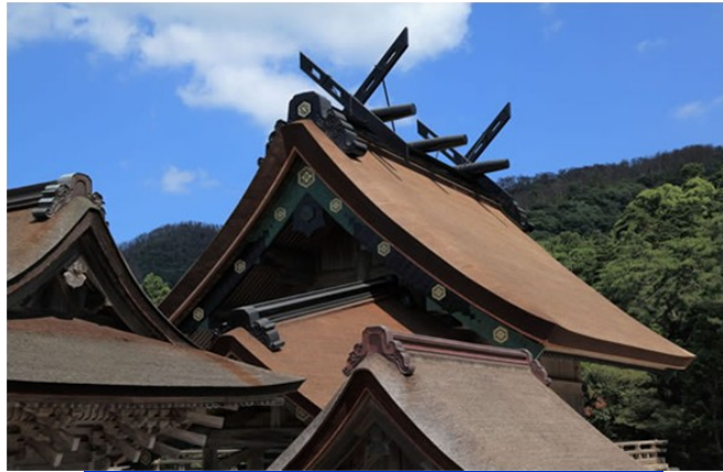
新装なった本殿(写真提供 島根県・出雲大社)
