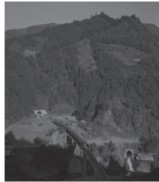
佐久間ダム建設で佐久間―大嵐間が水没するため水窪川を渡る迂回線の付け替え工事が行われ完成。一番列車が通過した。
